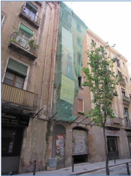
FOTO 1. Vista de la façana principal de l'edifici.
