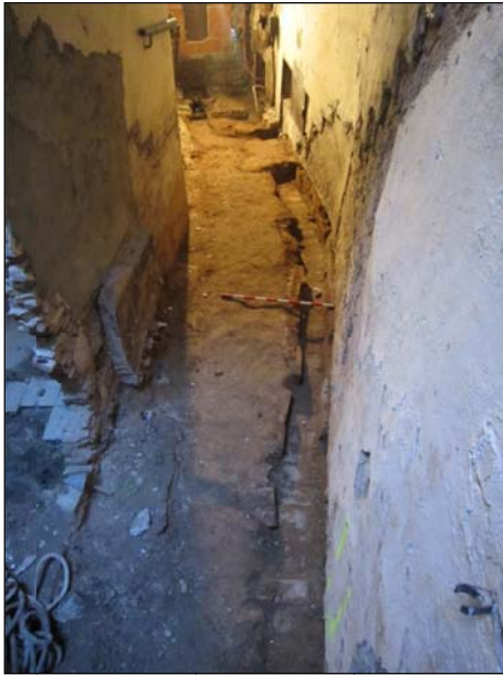
FOTO 33. Rasa 1. Vista del passadís després de realitzar el rebaix de 30 cm i abans de començar a excavar la rasa. A la dreta la canalització ue 12 provinent de l'aljub.
