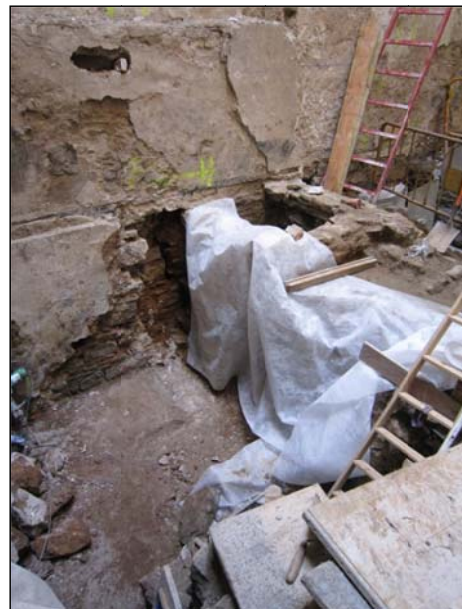
FOTO 40. Cala 1. Cobriment i protecció dels talls i estructures arqueològiques no afectades. En aquest cas, tall nord de la cala.
