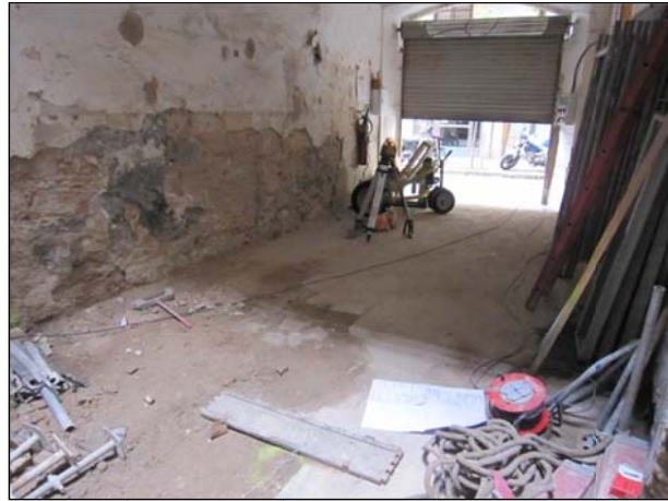
FOTO 2. Paviment de "terrazzo" i zona d'acopi de runa i materials constructius.
