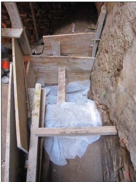
FOTO 39. Cala 1. Cobriment i protecció de les estructures arqueològiques no afectades. En aquest cas, mur de tancament del soterrani ue 03.
