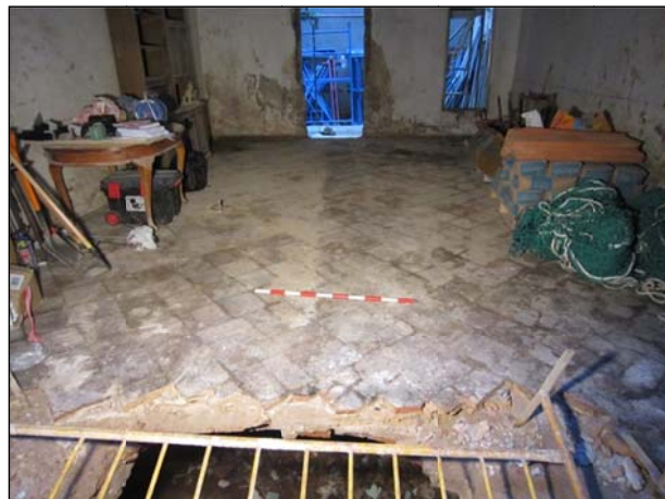
FOTO 4. Vista del paviment de rajols ue 02 a la banda posterior de l'edifici, sobre el soterrani.
