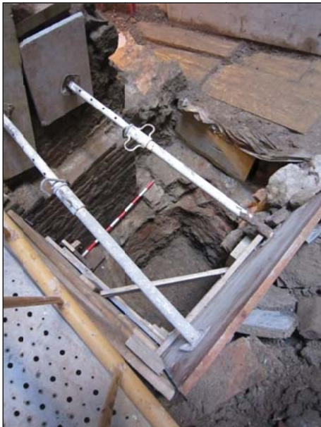
FOTO 19. Cala 1. Detall del pou (ue 72) localitzat sota l'aljub (ue 04).
