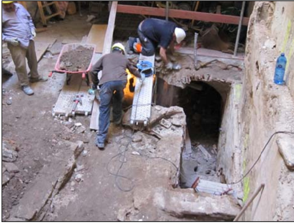
FOTO 13. Cala1. Treballs de desmuntatge de les escales d'accés al soterrani i part de la coberta del mateix.
