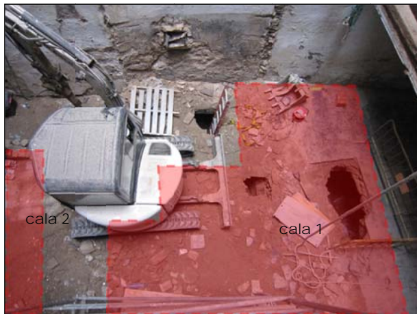
FOTO 5. Àrea on s'apila i es retira la runa provinent de l'enderroc de les plantes superior, i on es realitzaren les cales 1 i 2.
