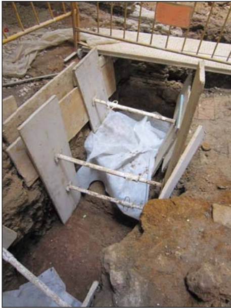
FOTO 41. Cala 2. Cobriment i protecció de les estructures arqueològiques no afectades. En aquest cas, la canalització ue 68 i el mur 74.
